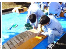
レンガのアーチ橋
